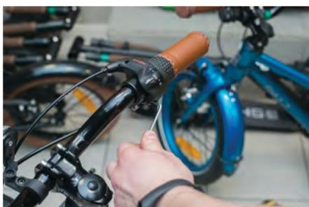
6с) Затяните болт крепления манетки (шестигранник 3 мм, усилие 4 Н·м).
